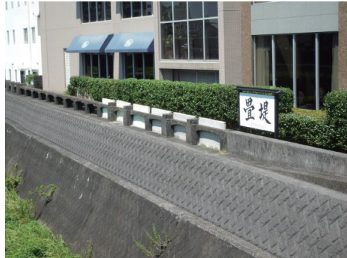
写真 14 五ヶ瀬川左岸の畳堤（延岡市紺屋町）
