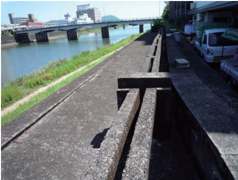
写真 13 五ヶ瀬川右岸の畳堤（延岡市北町）
