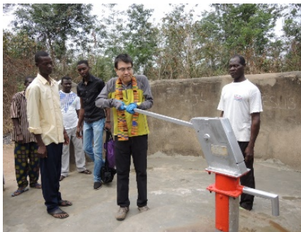
図1：井戸修理の様子（写真）
