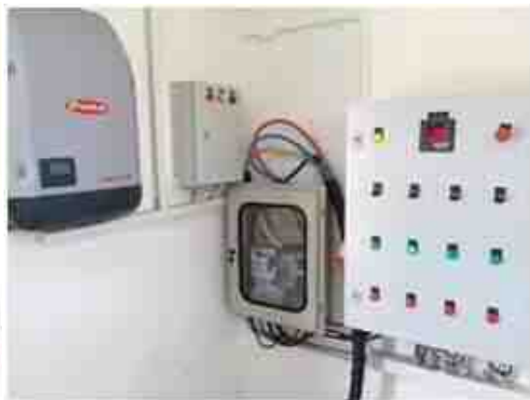
写真 4.3.10 制御盤設置状況
