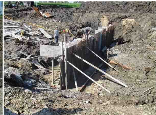
写真 3.1.4 上流部堰施工状況
