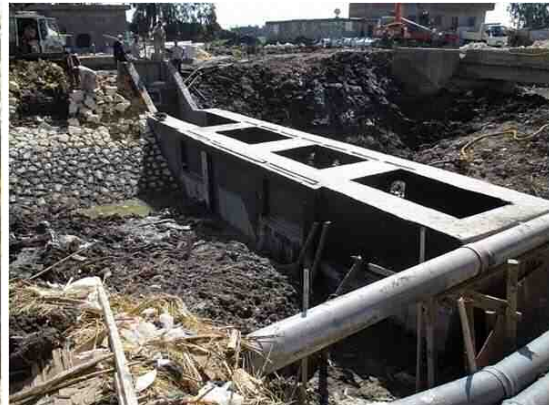
写真 3.1.2 施工状況（下流部堰）
