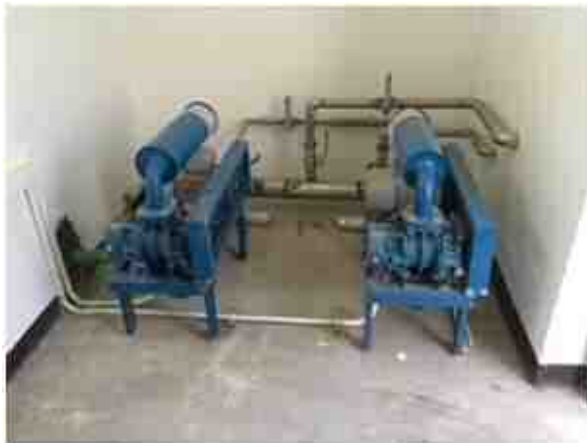
写真 4.3.9 ブローパー設置状況
