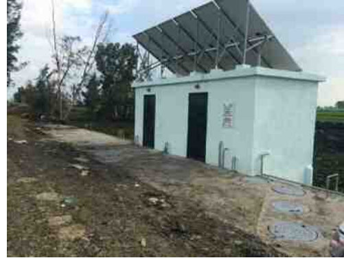
写真 4.1.1 集落排水処理施設全景
