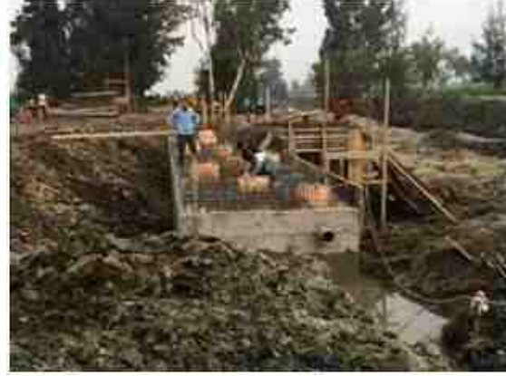
写真 4.3.4 頂版施工状況
