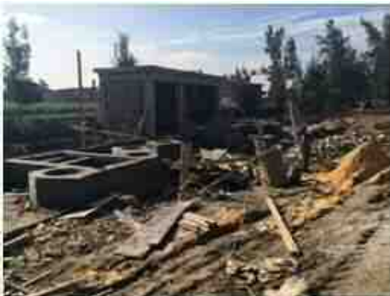
写真 4.3.5 土木建築工事完了写真
