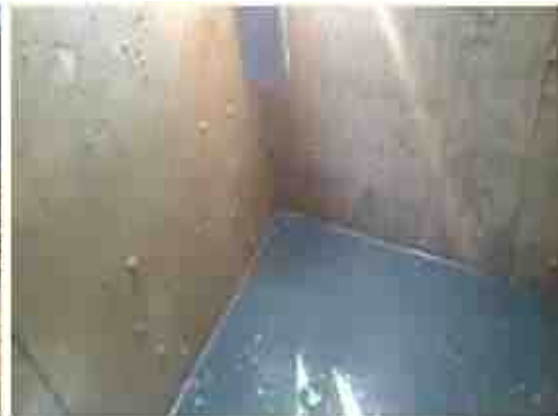
写真 4.3.6 沈殿分離槽内写真
