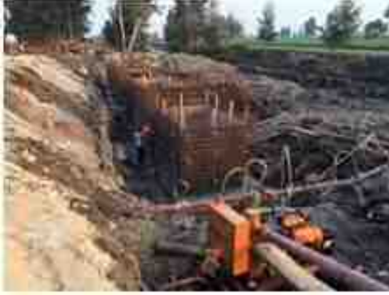
写真 4.3.3 側壁施工状況
