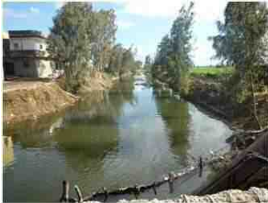
写真 3.1.1 水路内浄化施設建設前
