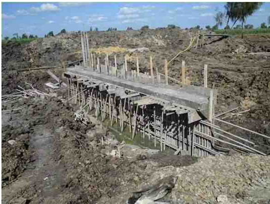
写真 3.1.3 中流部堰施工状況
