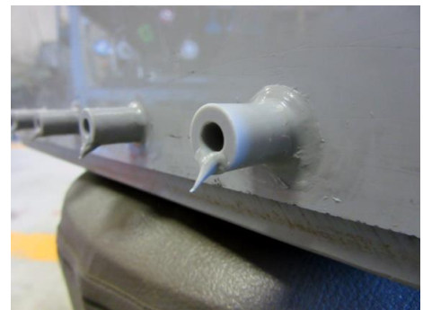
図 12 塩ビパイプ取付状況
