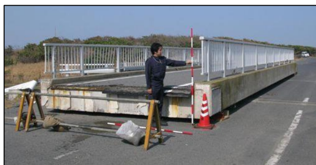
図3.2.2 流出した桁
