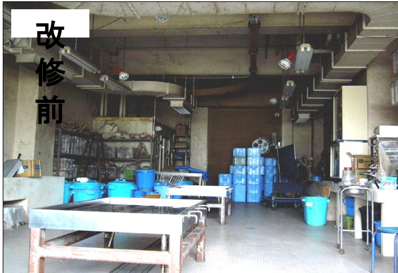
図3-13. 病理解剖室 (上:改修前 下:改修後)
