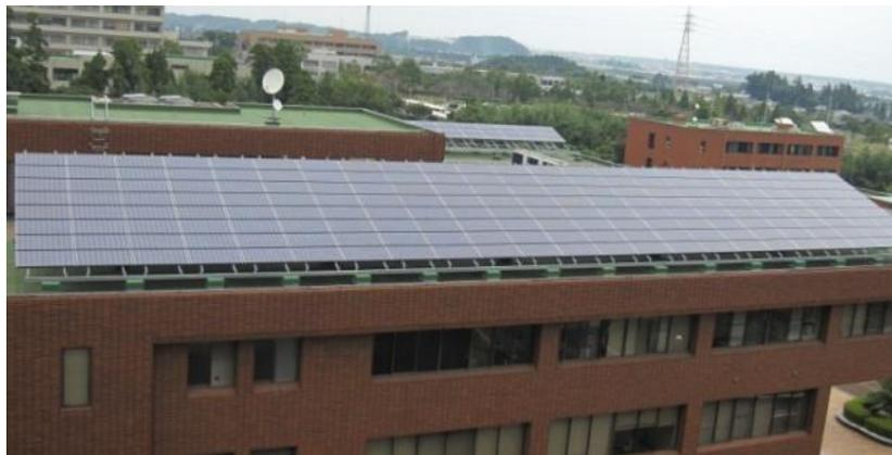
図 2.2 多結晶シリコン太陽光発電システム
