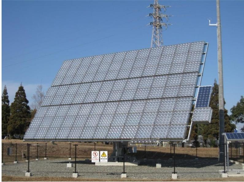
図 1.3 集光型太陽光発電システム (宮崎大学 14 kW)
