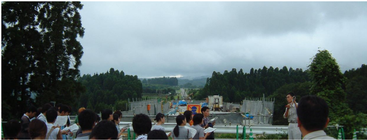
工事中を見学
