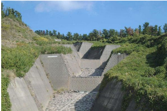
図5 野尻川上流に設置された砂防ダム
