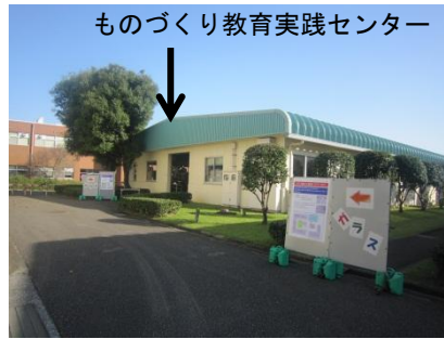
写真-2 案内板の設置状況
