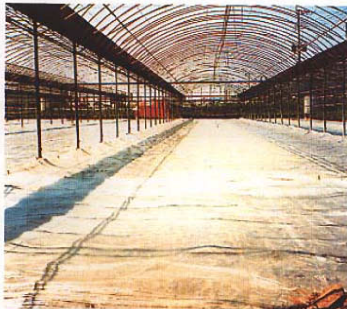
水田ハウス陽熱処理。湛水除塩後実施するが連作障害対策として効果が大きい。
