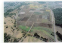
ほ場整備(西都原工区)
