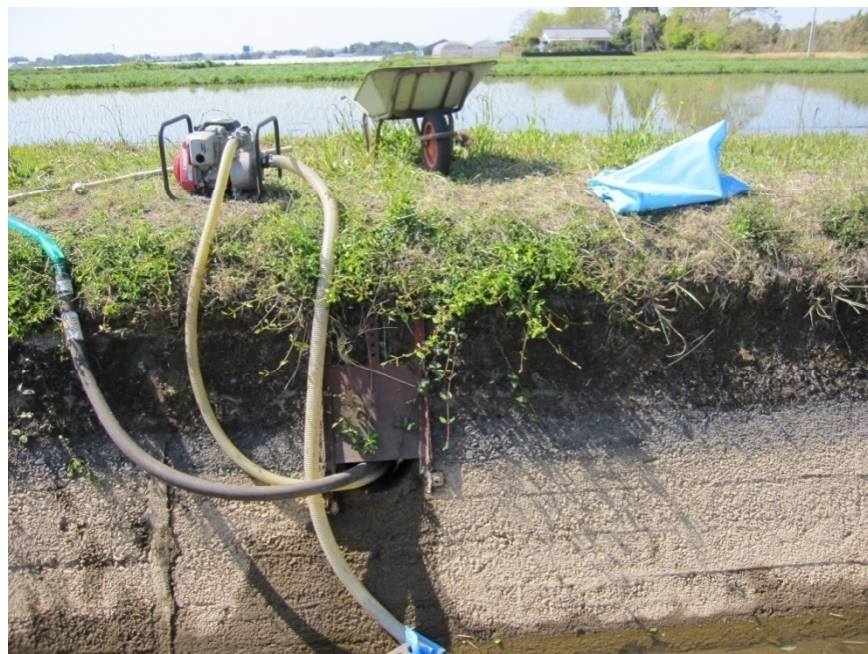
ポンプアップの様子 (4月14日撮影 土地改良区より)
