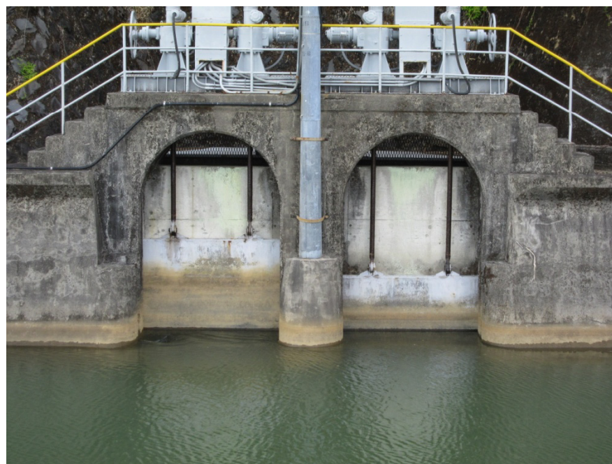
川南原用水取水ゲート (4月19日撮影 土地改良区より)
