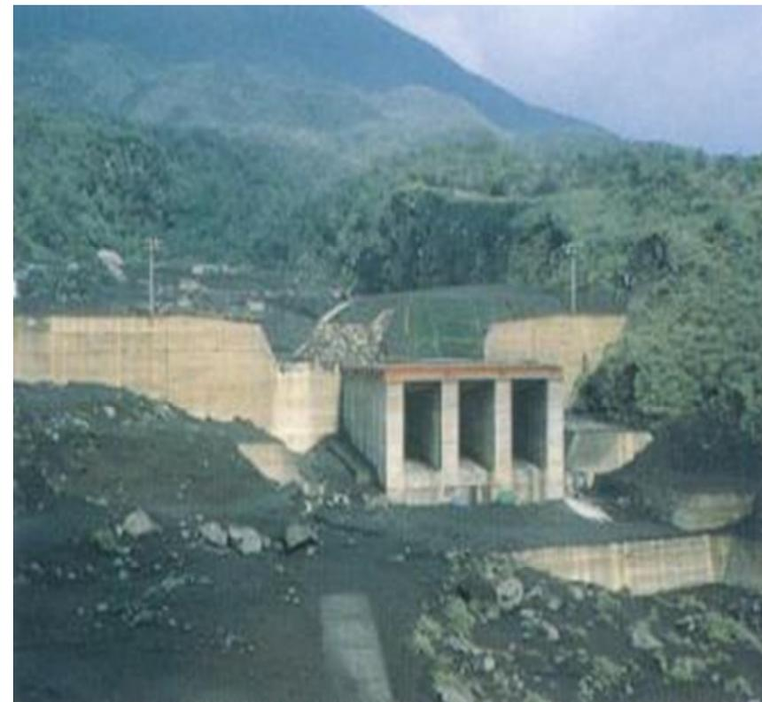
図6 水抜きスクリーンダム
