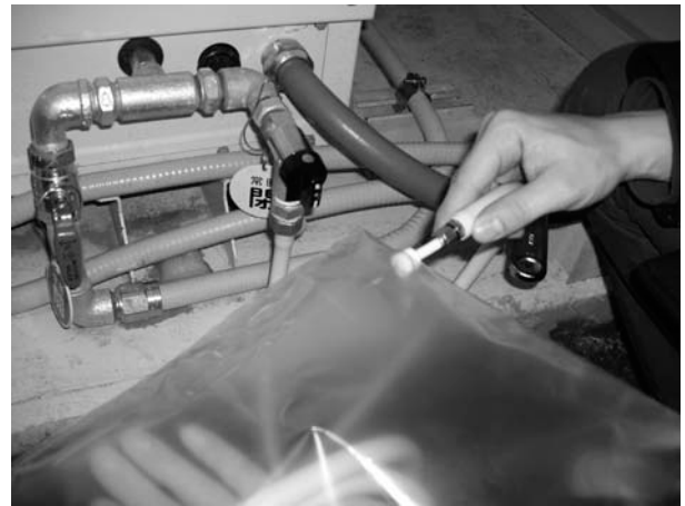
図8 分岐からのサンプルガスの採取
