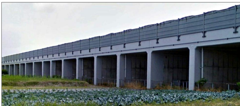
図 5.4-1 大型ボックス形式道路高架橋の写真例
