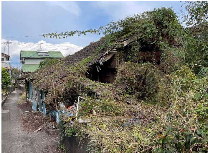
下浜地区で確認した空き家 (2021/11/03 撮影：甲斐)
