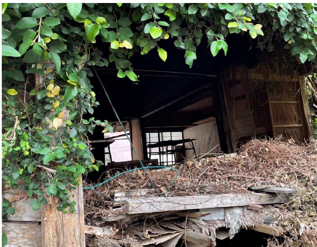
都農町下浜地区にて確認した空き家（2020/11/03 撮影：甲斐）
