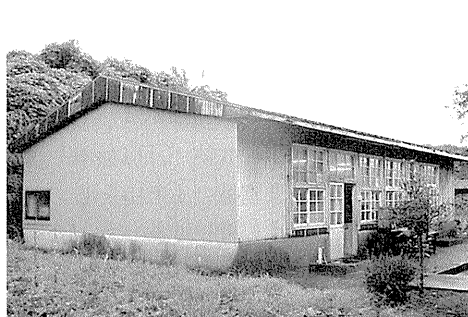
写真4 築35年以上の鉄骨造技術室
