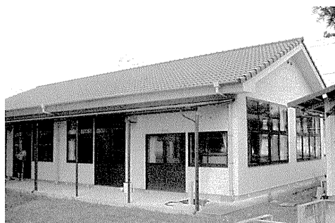
写真3 築10年以内の鉄骨造技術室
