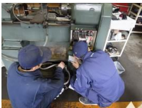
図 9 リレー交換時の配線確認
