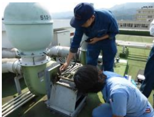
図 11 局所排気装置の簡易診断（平成 25 年度）
