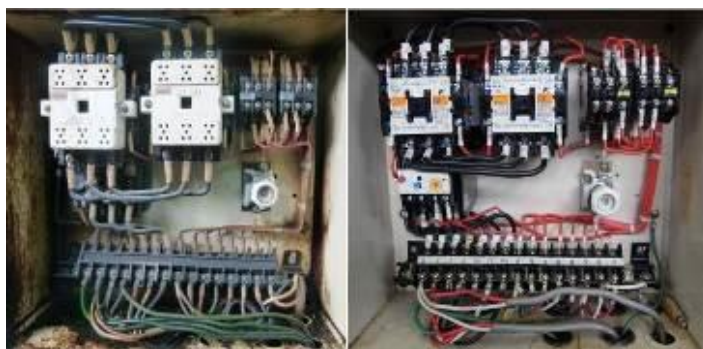
図 10 電気制御部のリレー交換（左：交換前 右：交換後）
